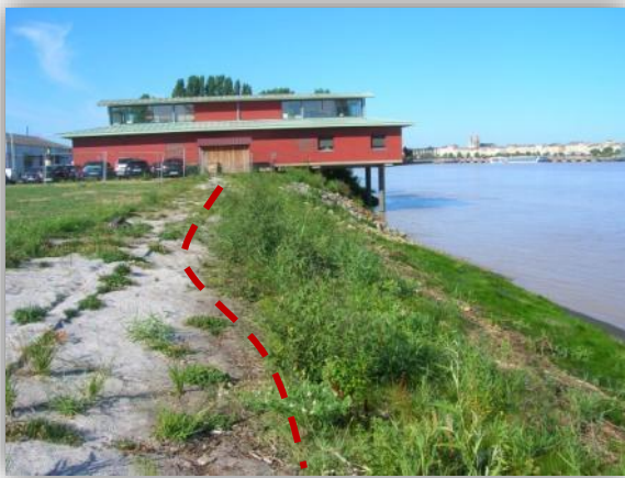
Revégétalisation artificielle en partie supérieure sur géotextile biodégradable (à gauche) et spontanée en partie inférieure sur géogrille anti-érosion (à droite), sur les digues en rive droite de Bordeaux (EC/CBNSA, août 2018). Moins de six mois après l'achèvement des travaux, on constate une très bonne reprise spontanée de la végétation sur la partie inférieure (non revégétalisée artificiellement), en particulier l'expression d'espèces caractéristiques des berges estuariennes.
