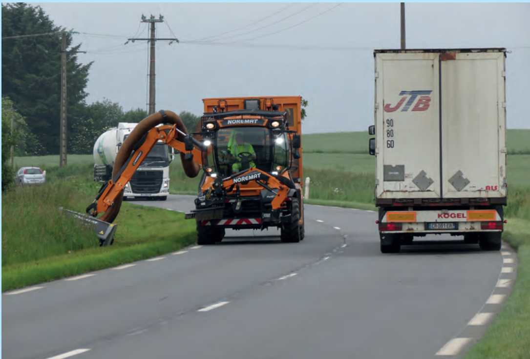
Fauchage-aspiration des accotements en courbe avec système VSV Noremat. © Cerema
