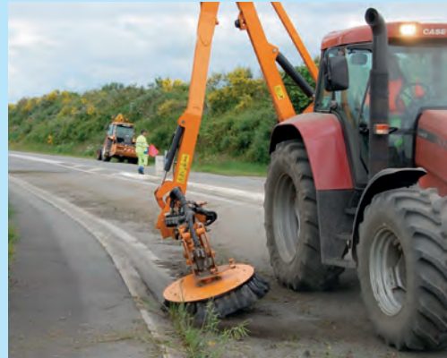
Désherbage par brosse des cunettes de trottoir. © DIR Ouest
