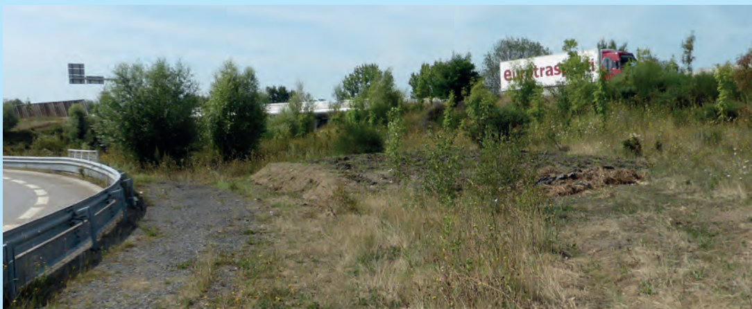
Dépôt de terre sur échangeur. © Cerema
