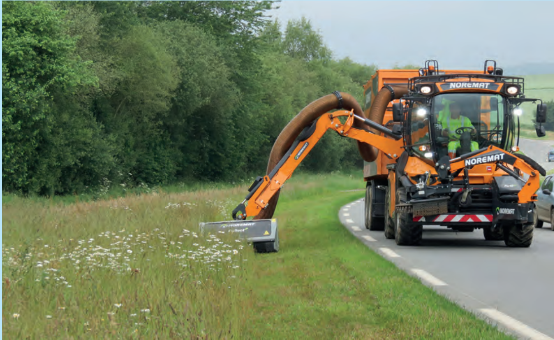
Accotement en courbe (Zone A) : 1 à 2 surlargeurs sur le virage. © Cerema
