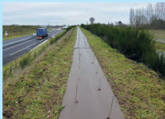
Végétalisation de talus. © Cerema
