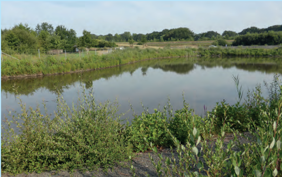
Bassin d'assainissement sur géotextile. © Cerema
