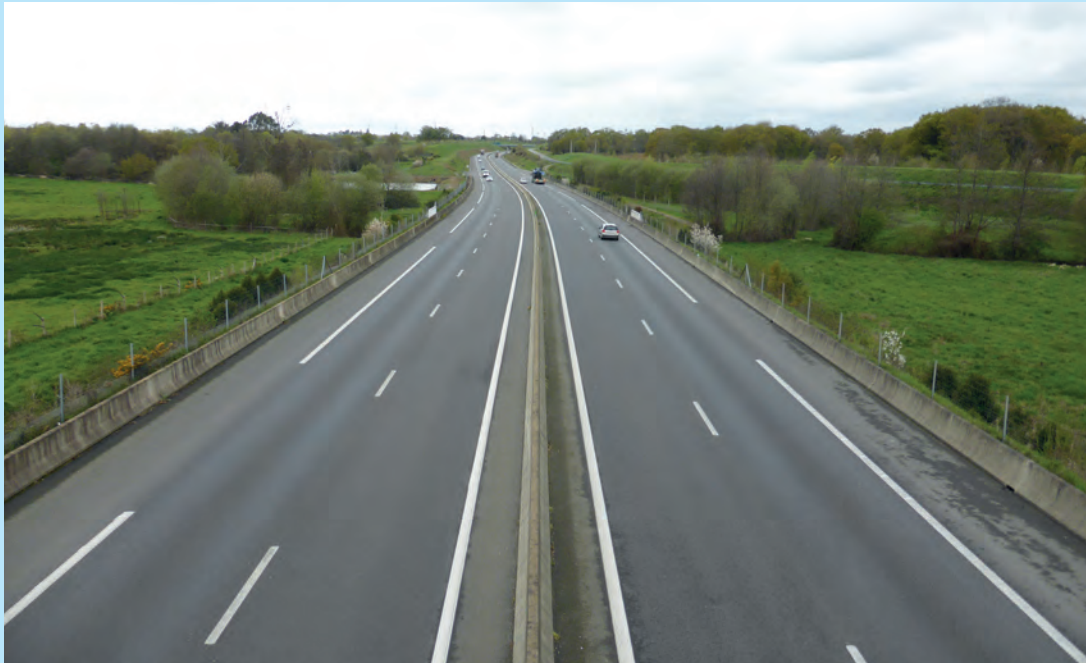
Gestion du trafic et entretien des chaussées. © Cerema
