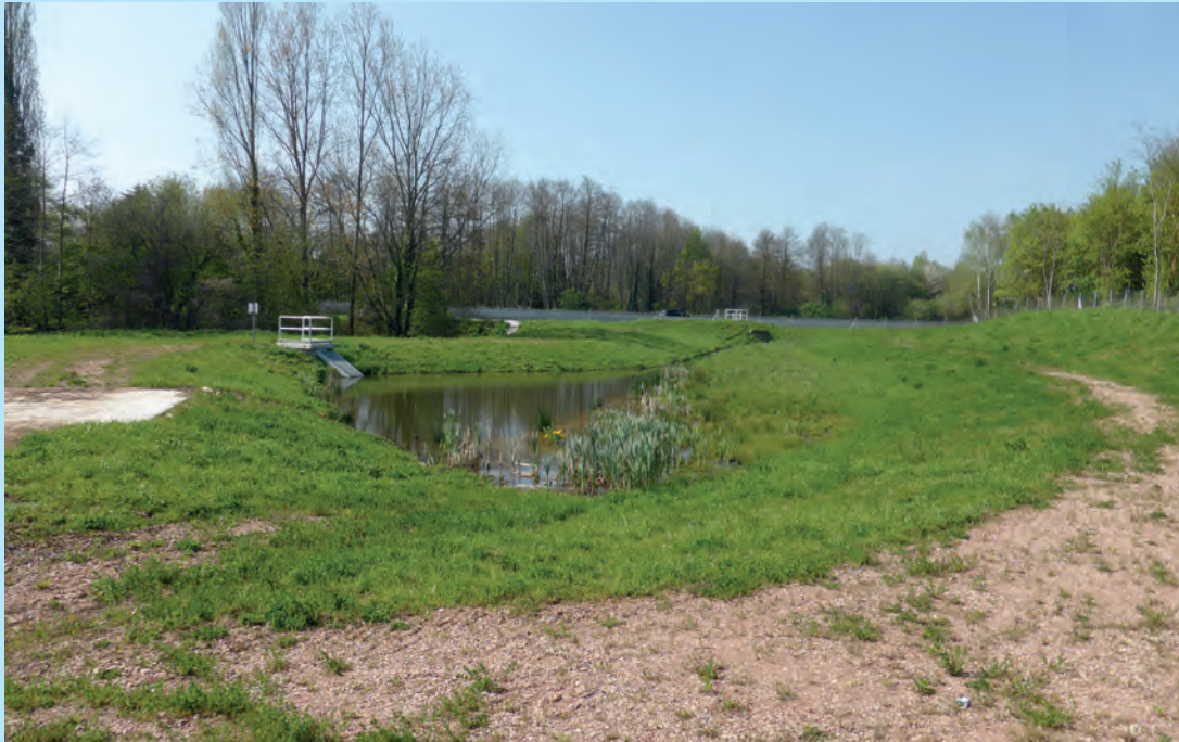
Bassin d'assainissement en terre. © Cerema
