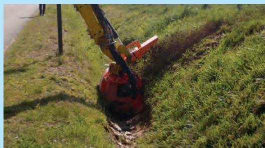
Curage à la rotocureuse. © CD Côtes d'Armor
