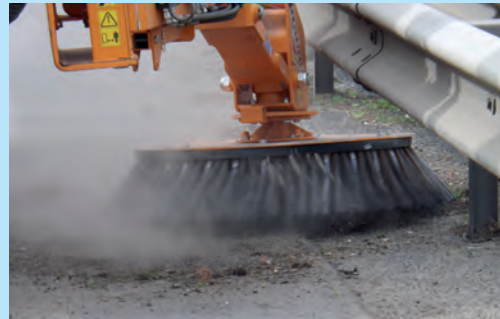
Nettoyage par brossage du terre-plein central. © Cerema
