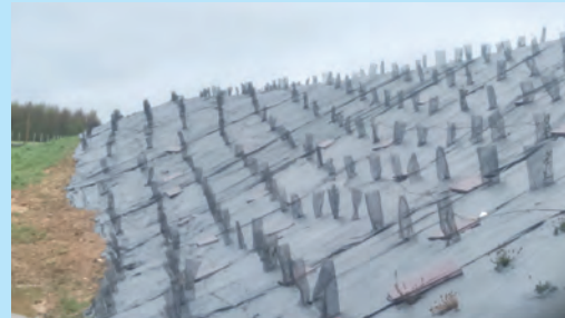
Plantation sur plastique n'offrant pas l'accès au sol. © Cerema
