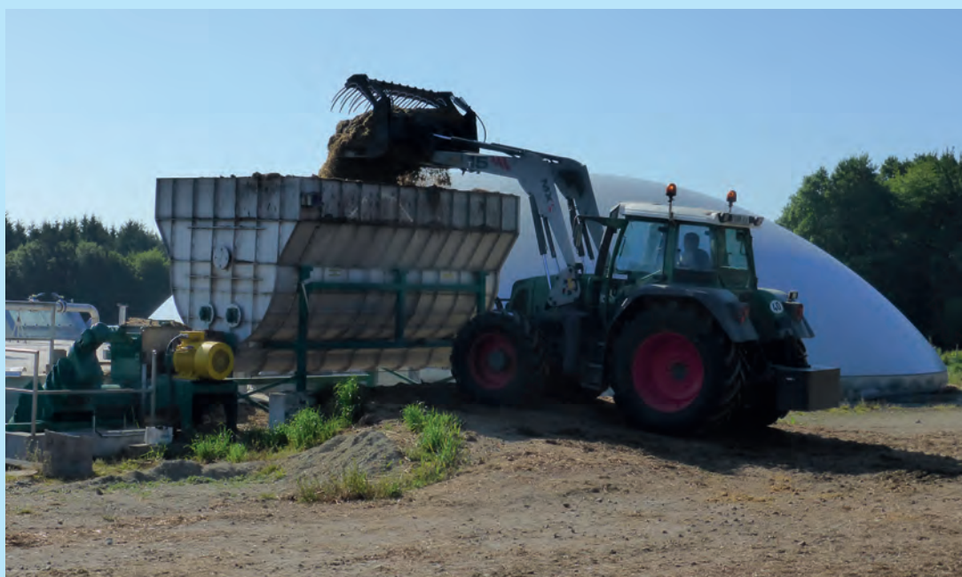
Site de méthanisation. © Cerema
