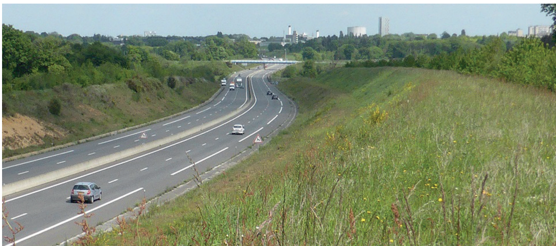
Diversité des formes de végétation sur les dépendances vertes (2x2 voies). © Cerema
