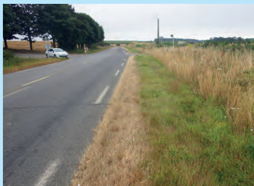
Gestion des accotements (1 passage d'engin).
