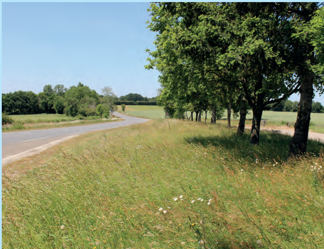
Aire de repos et de services en gestion extensive. © Cerema
