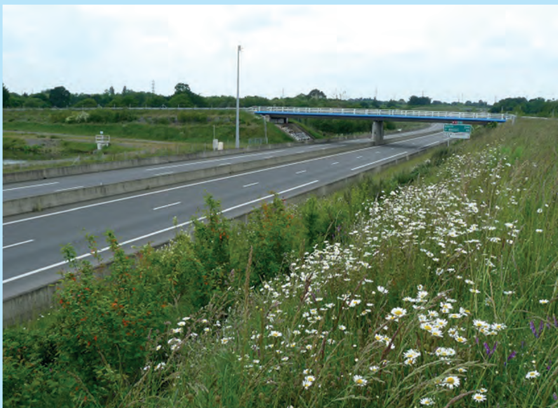
Dépendances vertes de 2x2 voies (50 m de large de chaque côté). © Cerema
