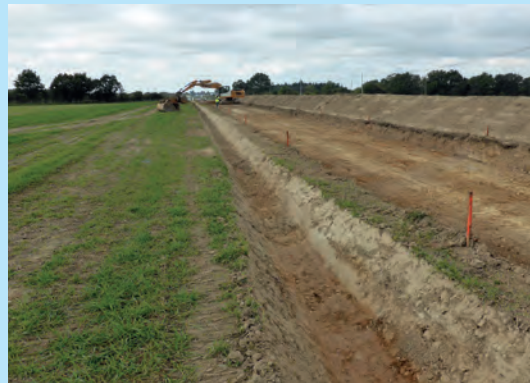
Végétalisation nécessaire lors des travaux. © Cerema
