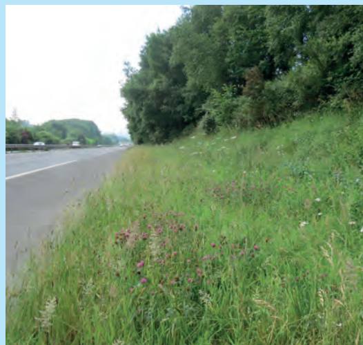
Zone ABC sur talus. © Cerema
