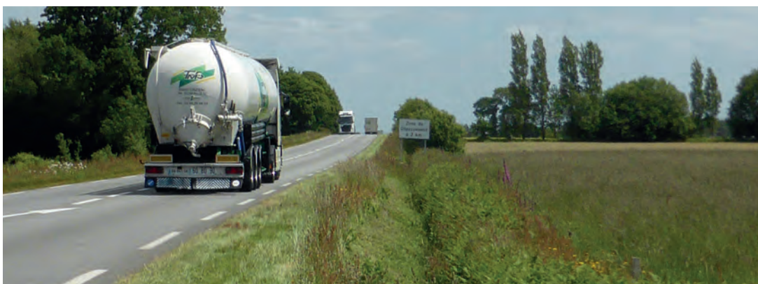
Diversité des formes de végétation sur les dépendances (voie bidirectionnelle). © Cerema
