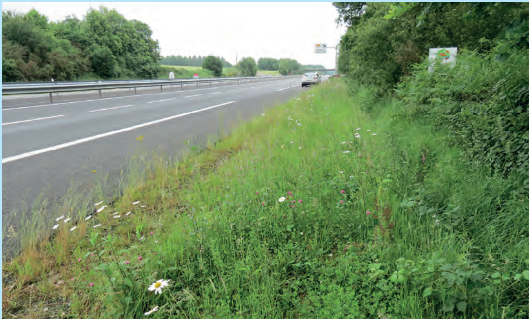
Accotement réduit (Zone A) : une largeur d'engin 1,5 à 2 m. © Cerema
