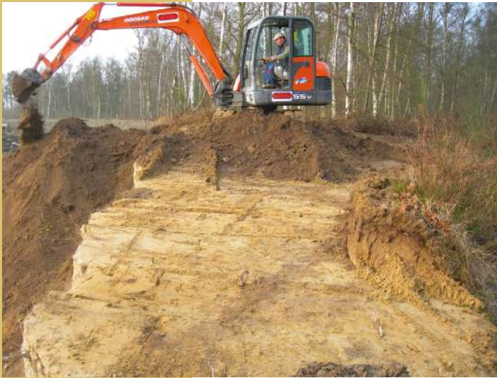
Décapage de la terre pour mettre en surface un substrat sableux pour les abeilles solitaires.
