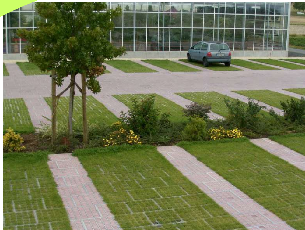
Parking combinant dalles engazonnées et passe-pieds en dalles pavées (société Sol-Aire)
